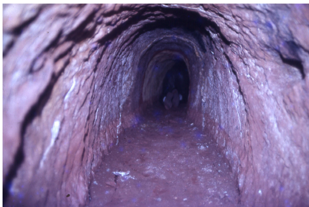
Figura 4. Galería romana de exploración (ternagus) de Riotinto.
