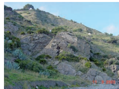
Fig. 3.- Deformación extensiva en macizo rocoso de cuarcitas aflorantes sobre el Peñón del Lobo (Almuñécar).
