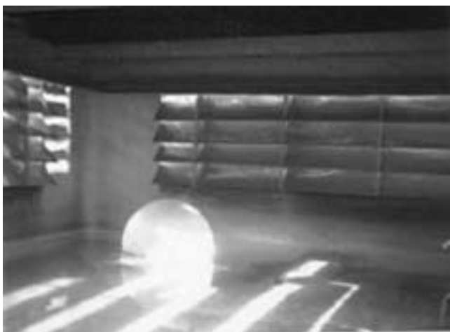
Figura 8: Aspecto correcto del interior de una torre
