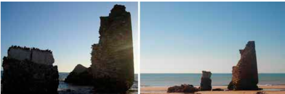
Figura 5. Imágenes que muestran la reciente fragmentación de uno de los bloques conservados de la torre (fotografías de Antonio Delgado Pinto y de los autores).
